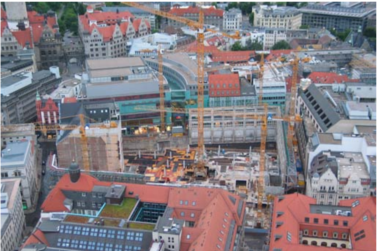
Abb. 4: Blick auf die Baumaßnahme, aufgenommen vom City-Hochhaus Leipzig
