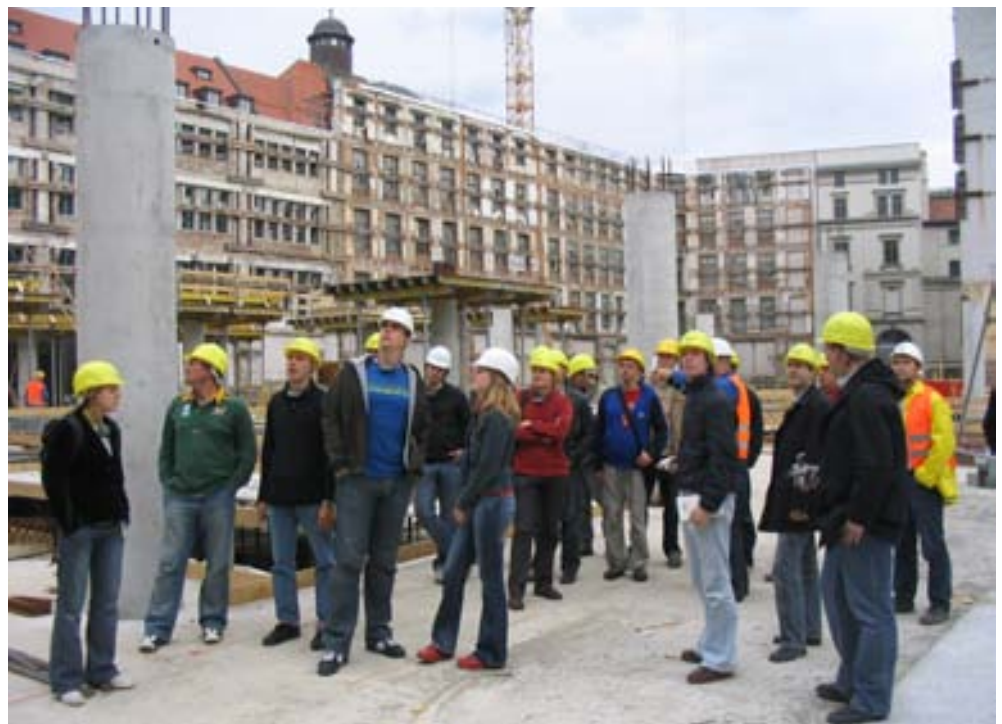
Abb. 3: Studierende auf der Baustelle Karstadt Leipzig
