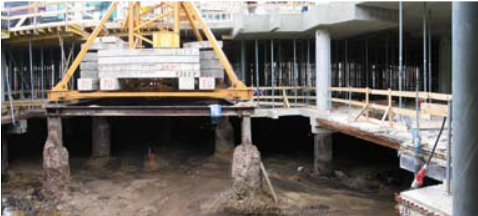
Abb. 2: Deckelbauweise: gleichzeitiger Baufortschritt nach oben und unten
