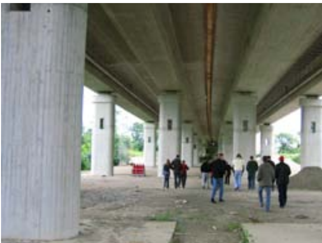
Abb. 7: Pfeiler mit Aussparungen
