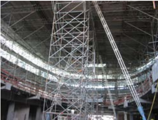
Abb. 7: Rüstturm im Mallbereich
