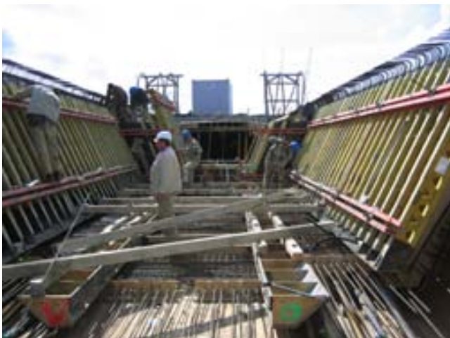
Abb. 1: Schalarbeiten
