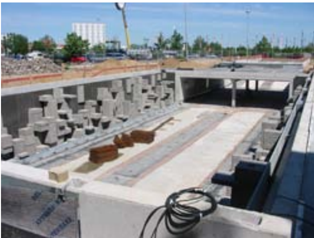
Abb. 8: Außenanlage – Zufahrt zum Parkhaus
